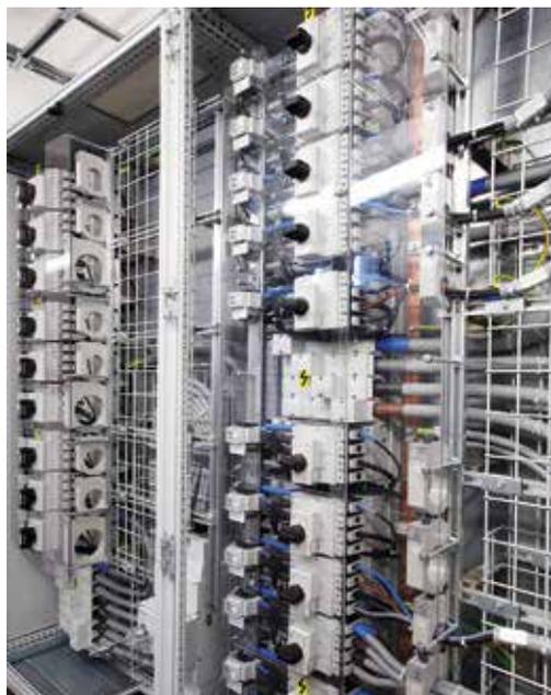
Die Energieverteilung der Produktionsanlage: Zum Einsatz kommen Eaton Kompaktleistungsschalter NZM von 160 A - 630 A
