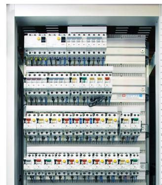
Der Leitungsschutzschalter FAZ verfügt über eine Kontaktstellungsanzeige rot-grün, Klemmhilfe, Hintersteckschutz, tristabilen Rastschieber und eignet sich für Bemessungsströme bis 63 A
