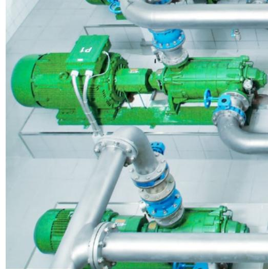
Die höheren Anlaufströme bei IE3-Motoren sorgen dafür, dass die zugehörigen Motorsteuergeräte wie Schütze und Motorschutzschalter modifiziert werden müssen.
