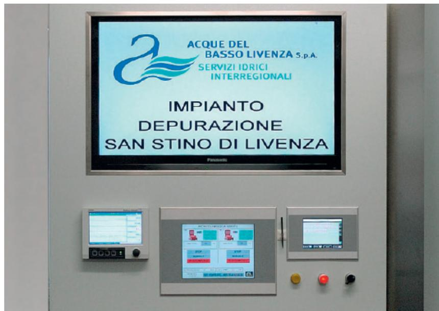
Die Steuerung und Bedienung der Anlage erfolgt über ein Industrie-PC und zwei Touch-Display Steuerungen. Die integrierte Ferndiagnose erhöht deutlich die Anlagenverfügbarkeit.
