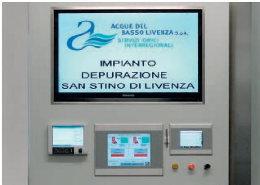
L'impianto è controllato e gestito con un PC industriale e due unità di controllo con display touchscreen, mentre la funzionalità integrata di controllo remoto ne incrementa la continuità di servizio.
