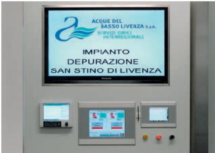
La station est contrôlée et exploitée via un PC industriel et deux unités de contrôle à écran tactile, la fonctionnalité de contrôle à distance intégrée contribuant à augmenter la disponibilité.
