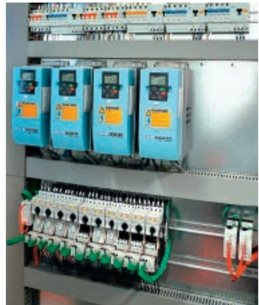
Les convertisseurs SLX9000, les disjoncteurs-moteur PKE et la technologie SmartWire-DT permettent d'économiser du temps et de l'espace.
