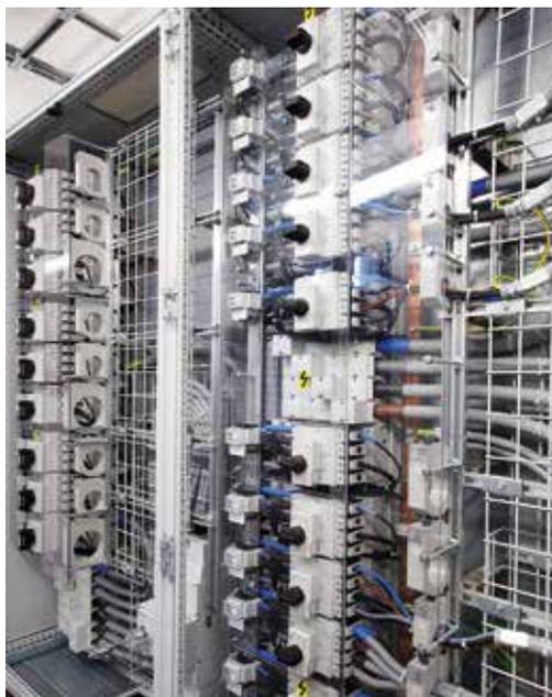
Le système de distribution électrique de l'installation de production intègre des disjoncteurs NZM Eaton d'encombrement réduit, adaptés à des intensités allant de 160 à 630 A.
