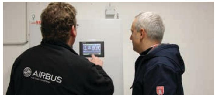
Eatons BreakerVisu sammelt alle Daten von den Leistungsschaltern, vom Diagnosesystem zur Temperaturmessung sowie dem Störllichtbogenschutzsystem Arcon ein und kommuniziert über Modbus direkt mit der Gebäudeleittechnik
