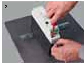
2 Hauptstrombahnen anschließen.
